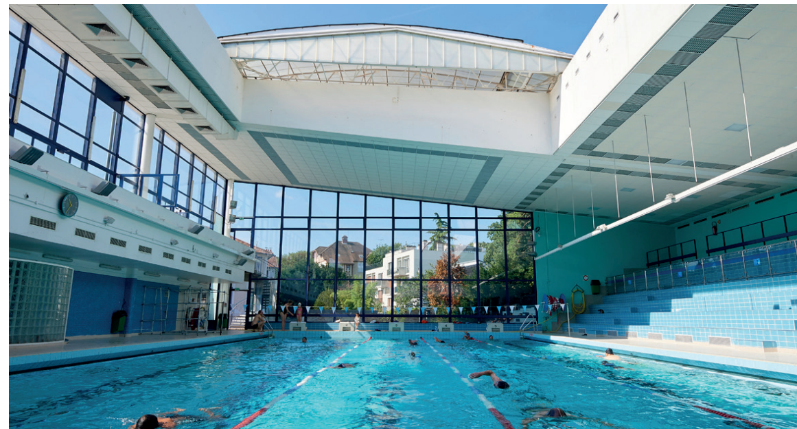
La piscine des Raguidelles et son toit ouvrant
