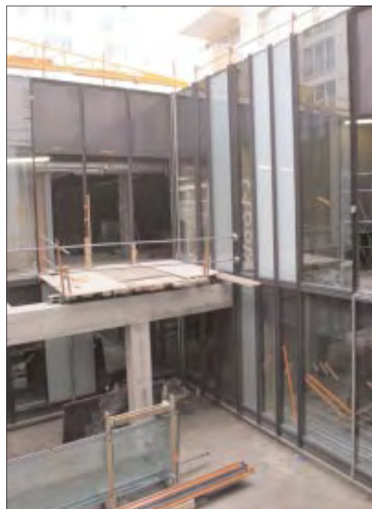
Le patio du conservatoire. Tout a été fait sur mesure. Le vitrage est composé de vitres très épaisses (environ 5 cm) pour une insonorisation optimale.
