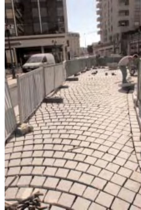
Rue des Bourets : les travaux s'achèvent.
